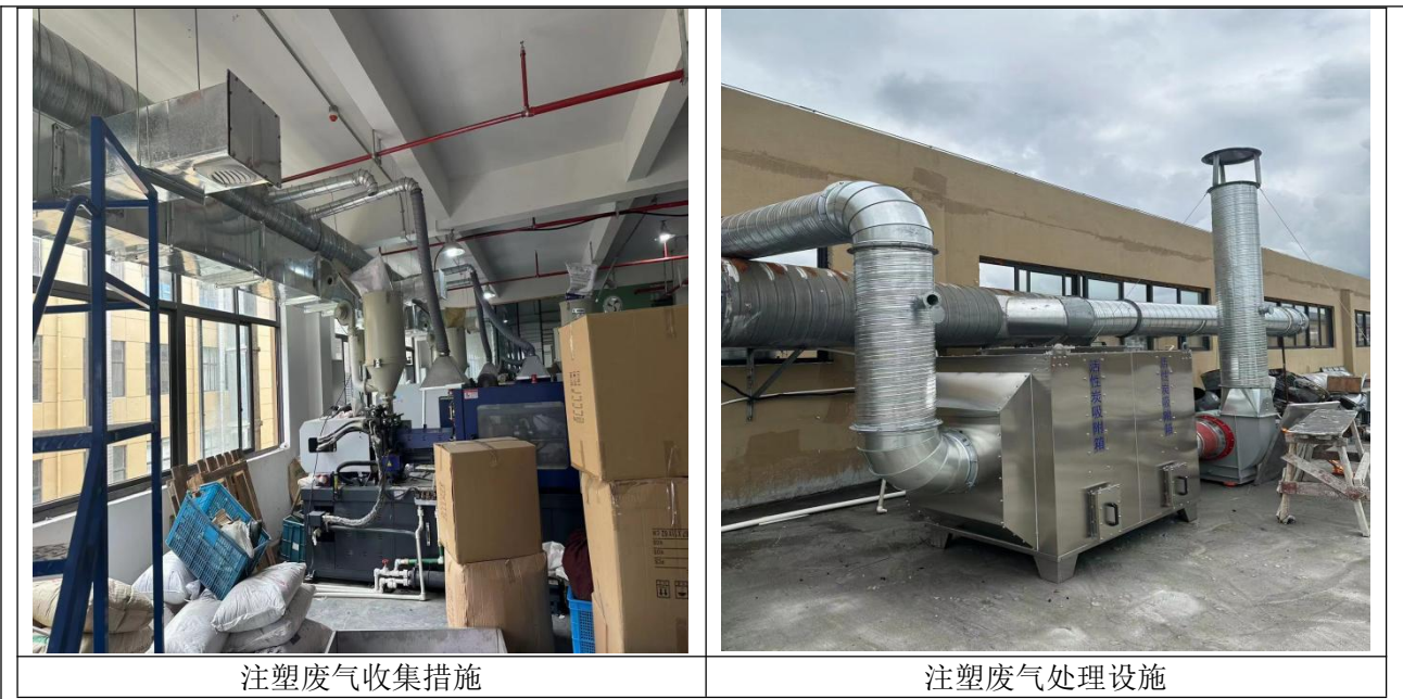
图 4-4 现场防治情况
