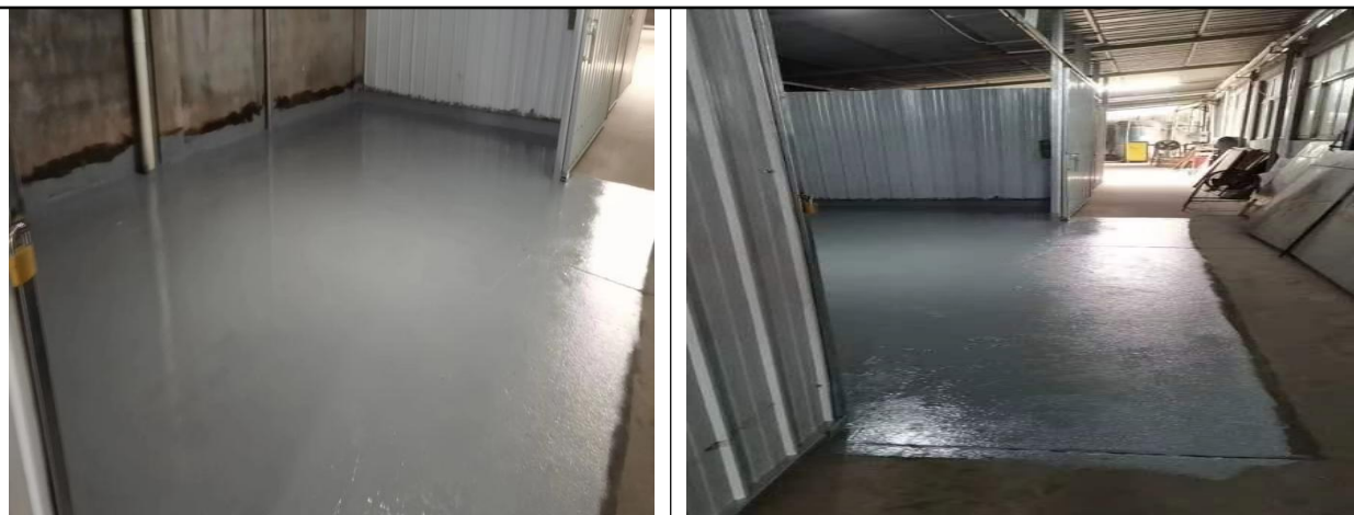
危废间建设情况
