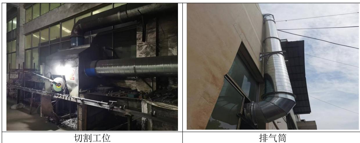
图 3-2 项目废气产污结点和处理设施现场图
